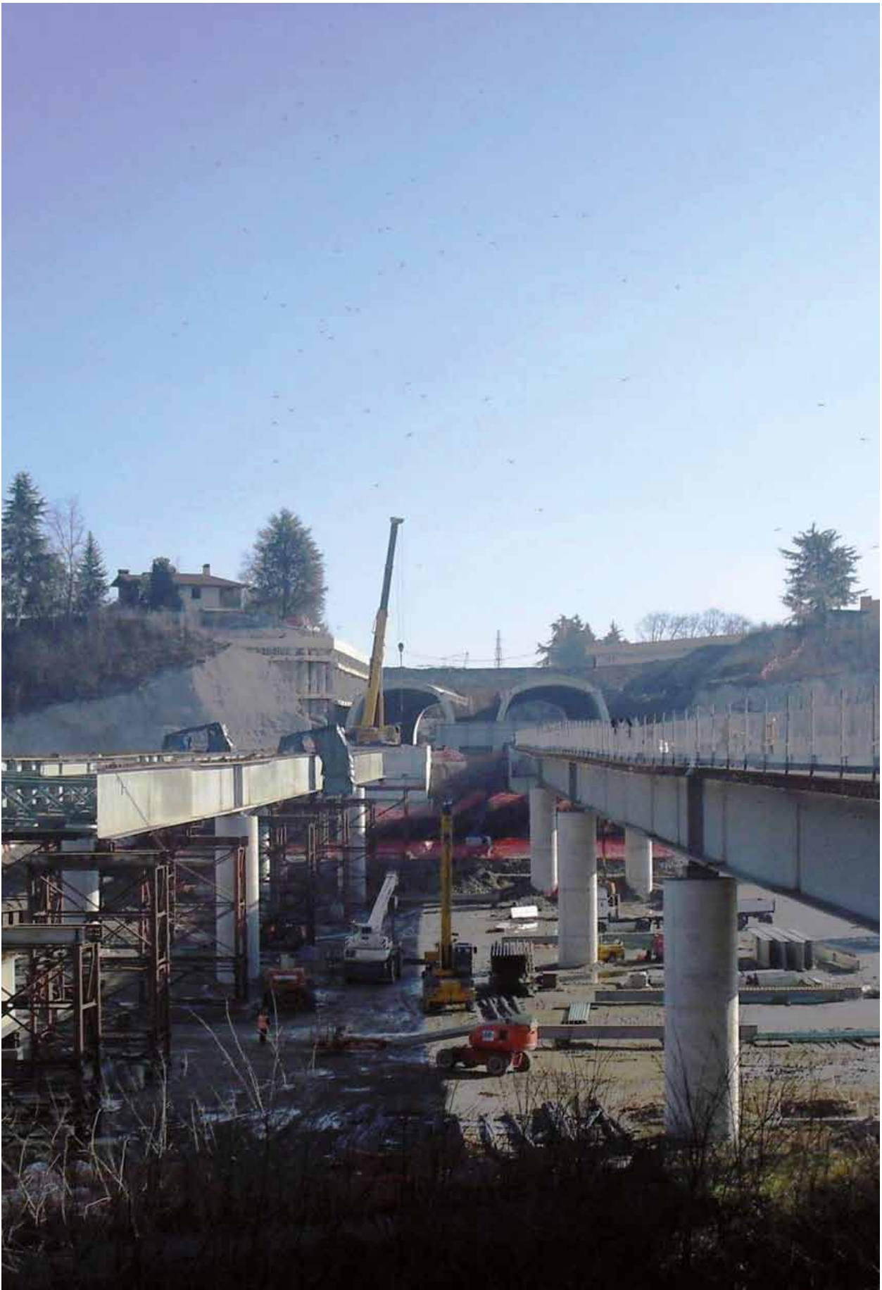
APL Viadotto Solbiate Olona
